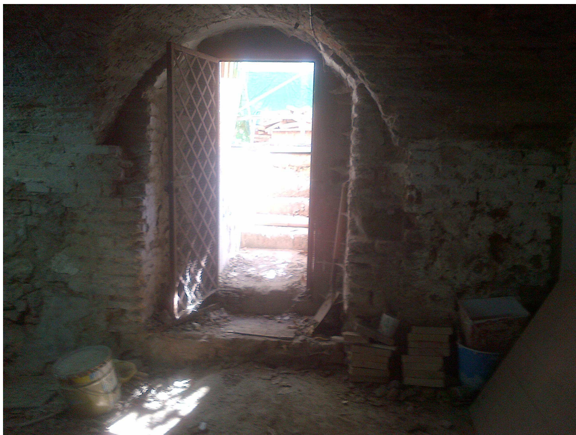
Interior entrada primera galería
